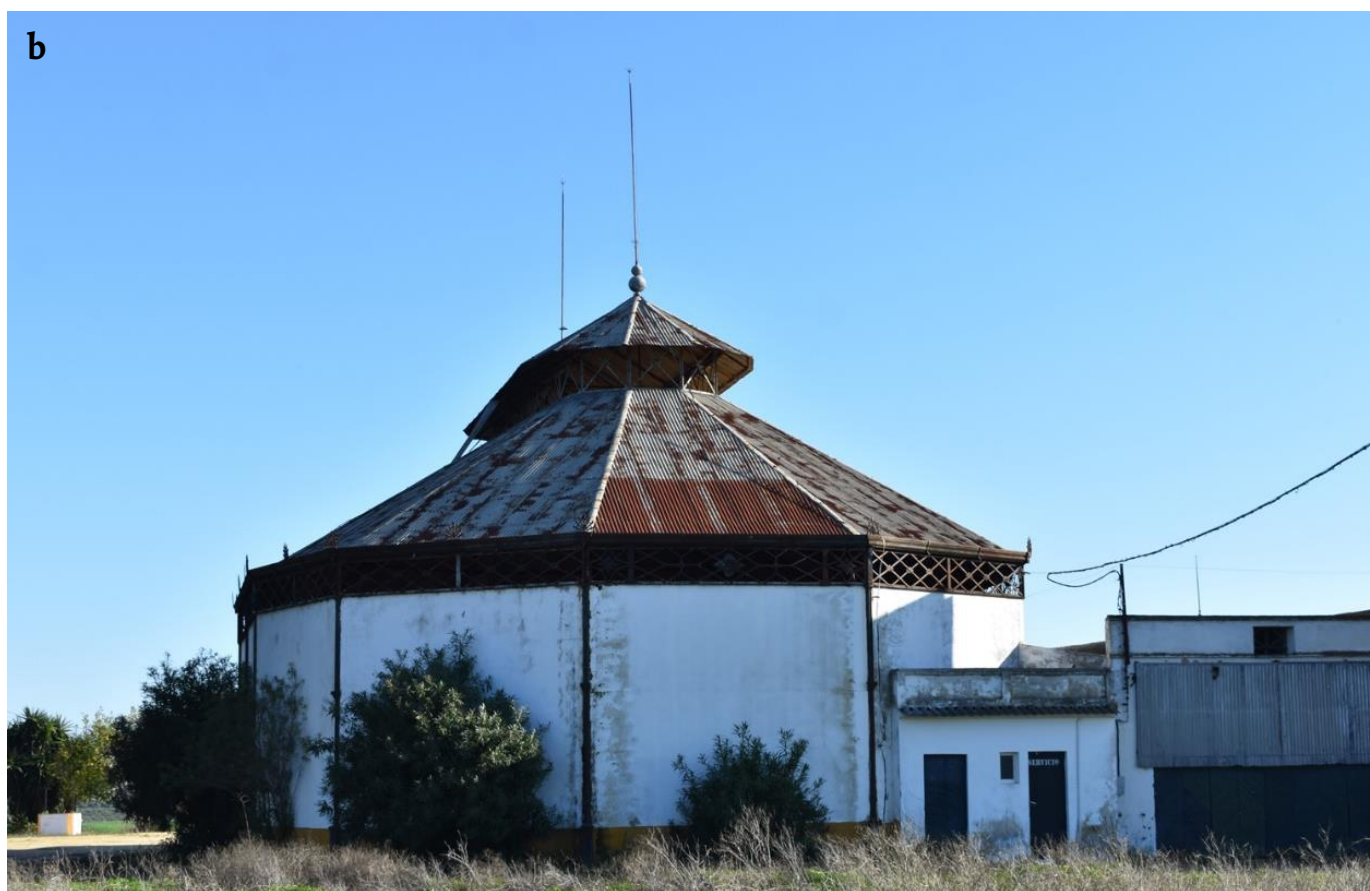
Figure 3. View of the old Círculo de Labradores de Sevilla fair booth, later, El Majuelo de Soto de Bollullos Par del Condado Winery, Huelva: a) main façade; b) rear façade (photographies: Sheila Palomares Alarcón, 2020).
