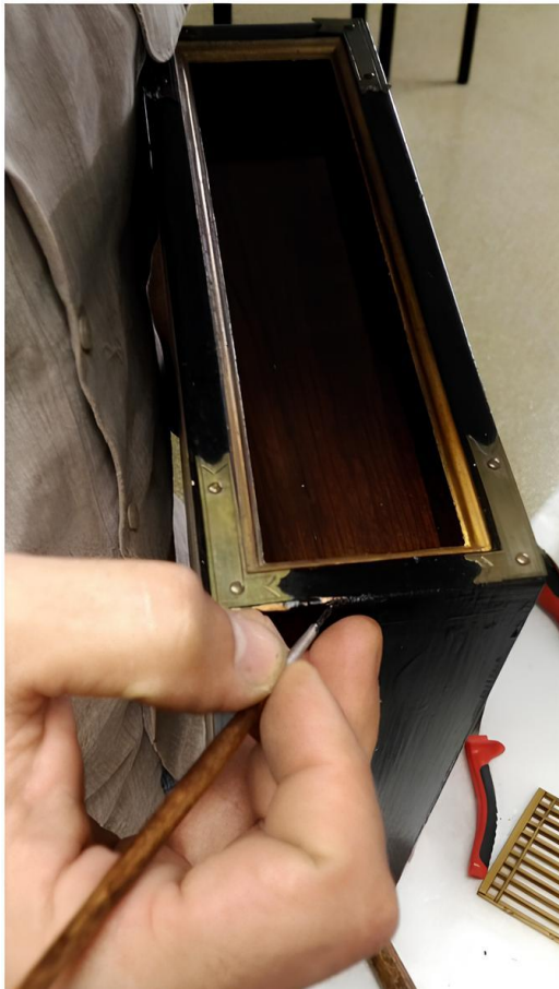
Figura 12. Reintegração cromática da gaveta exterior esquerda.
