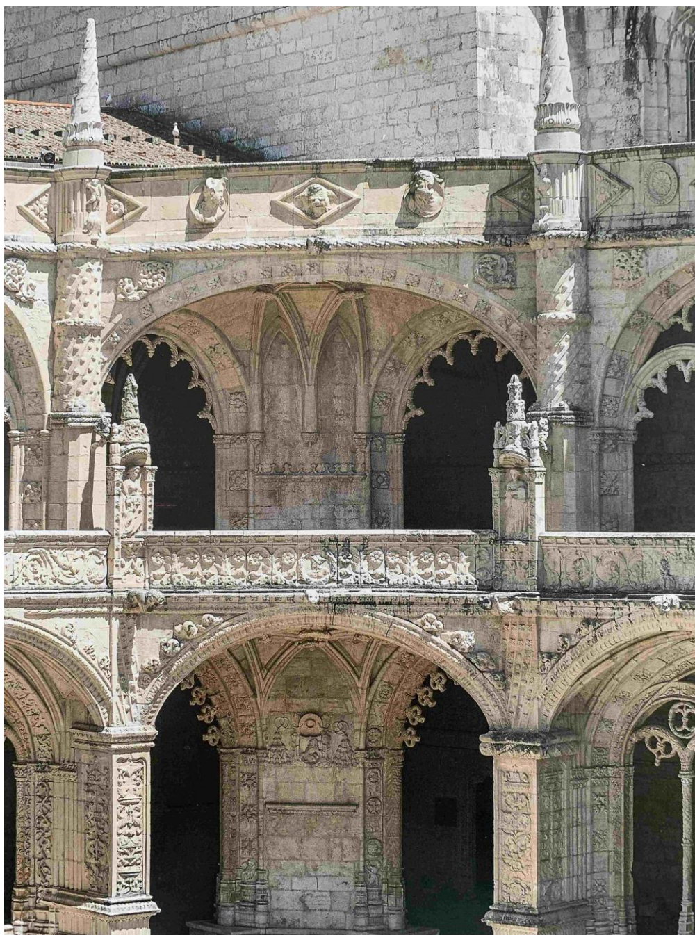
Figura 9. Claustro do Mosteiro de Santa Maria de Belém, ângulo sudeste (2013), fotografia de António Serralheiro.
