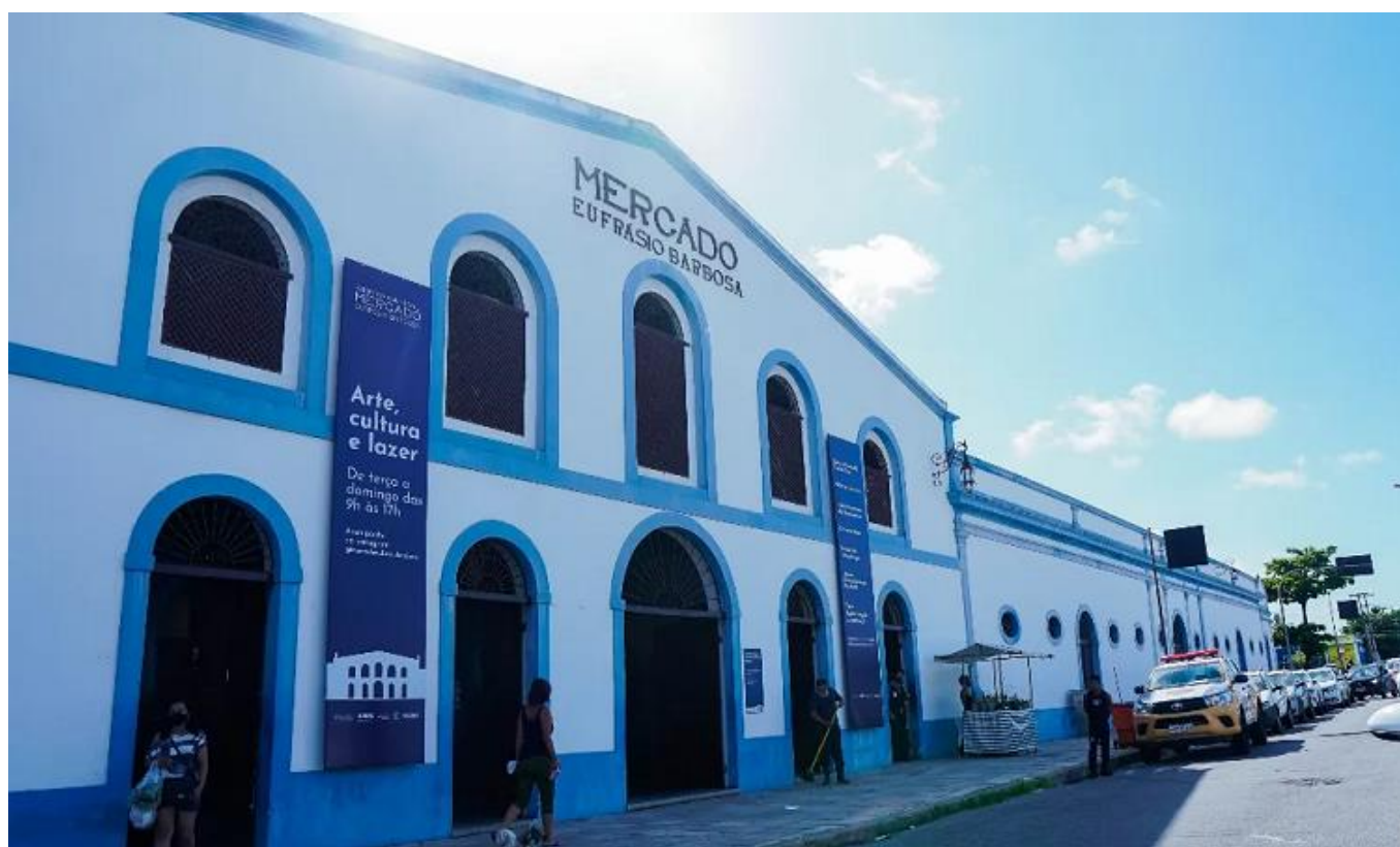
Figura 10. Mercado Eufrásio Barbosa após execução dos serviços de manutenção prescritos nas fichas de danos.
