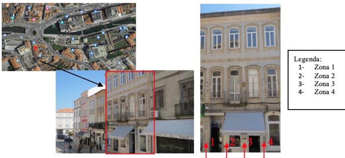
Figura 1. Localização do edifício em estudo.
