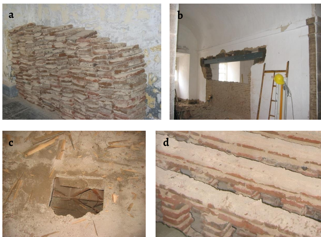
Figura 10. Elementos cerâmicos aplicados na construção: a) ladrilhos avulsos; b) parede com estrutura em ladrilho; c) e d) ladrilhos aplicados sob o pavimento (créditos de imagem: CME, 2005, 2006).
