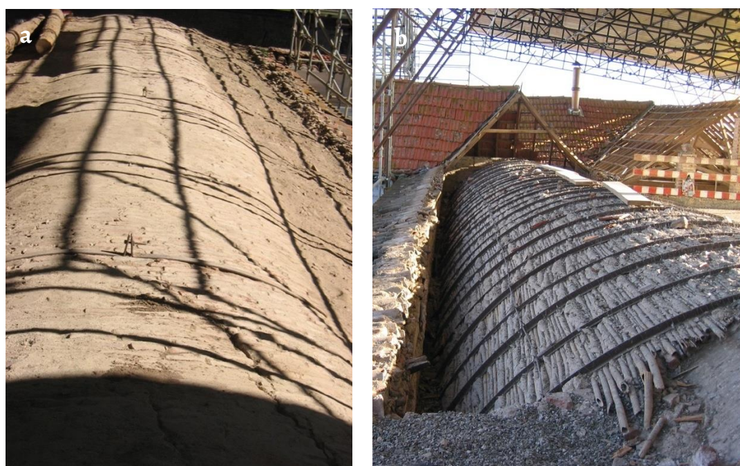
Figura 8. a) Abóbada composta por elementos cerâmicos e construída no período jesuíta; b) Falsa abóbada composta por canas e perfis metálicos construída após 1759 (créditos de imagem: CME, 2006).
