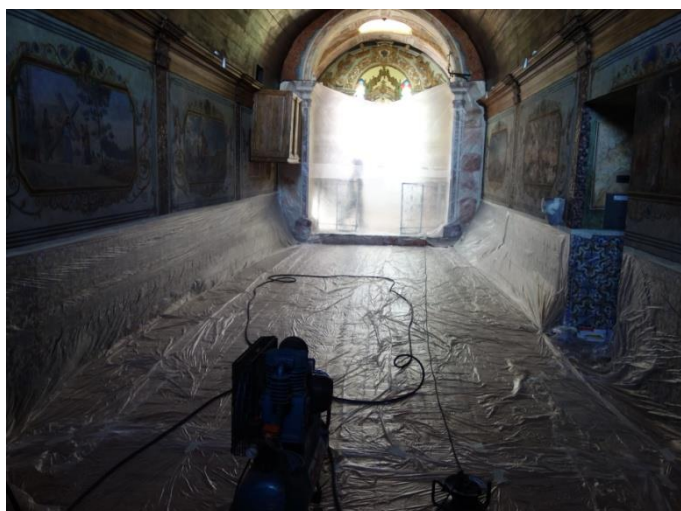
Figura 12. Interior do Santuário de Nossa Senhora da Piedade com as protecções necessárias à aplicação do verniz de acabamento, por pulverização, em áreas seleccionadas.
