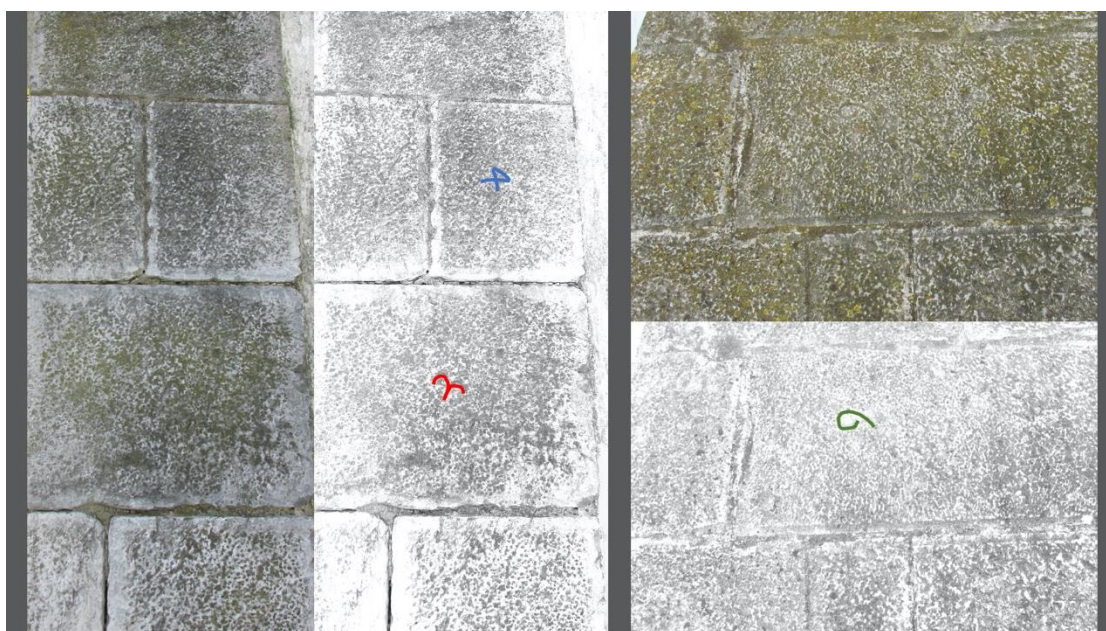
Figura 13. Fotografias e esquema de marcas de pedreiro, situadas na vertente noroeste do embasamento do edifício.
