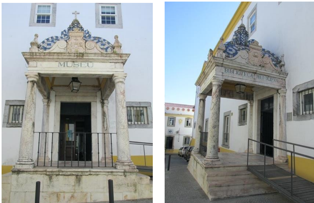
Figura 14. Alpendre da portaria em mármore da região e materiais cerâmicos: a) vistas norte e b) nascente.
