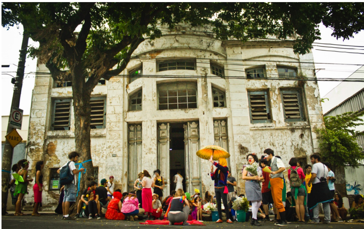
Figura 1. Fachada frontal da edificação à época de sua ocupação (2013) (foto: Priscila Musa).
