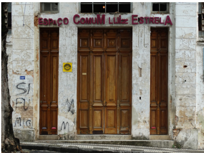
Figura 12. Parte da fachada frontal da edificação com as portas restauradas (2021) (foto: Ciro Martins).
