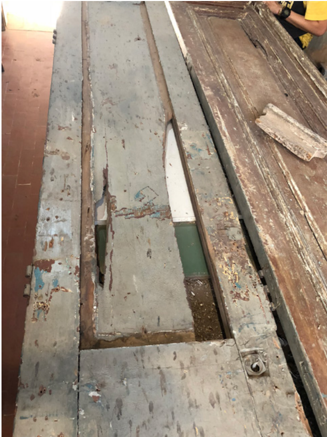
Figura 4. Perdas de partes do suporte por golpe mecânico (2017) (foto: Tatiana Penna).
