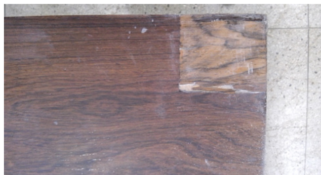
Figura 2. Lâmina de madeira aplicada em reforma anterior e não documentada (fonte: Acervo IFB, 2018).
