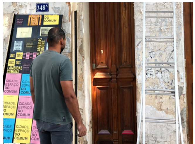
Figura 13. Parte inferior das portas laterais esquerdas com próteses instaladas (2019) (foto: Tatiana Penna).
