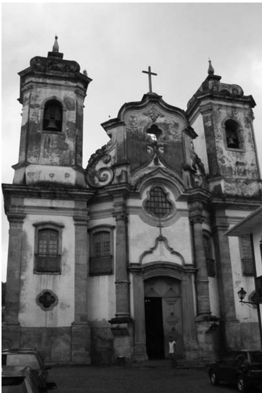
Fig. 1 Matriz de Nossa Senhora do Pilar, Ouro Preto, Minas Gerais. Foto: Alexandre Mascarenhas.
