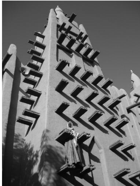
Fig. 16 Mali, mesquita de Mopti. Reboco liso sobre paredes de adobe.
