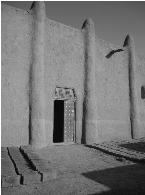
Fig. 7 Mali, mesquita de Djenné. Vista da entrada lateral.
