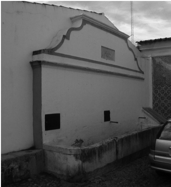
Fig. 11 Chafariz do Largo de São Mamede: vista geral antes da intervenção.
