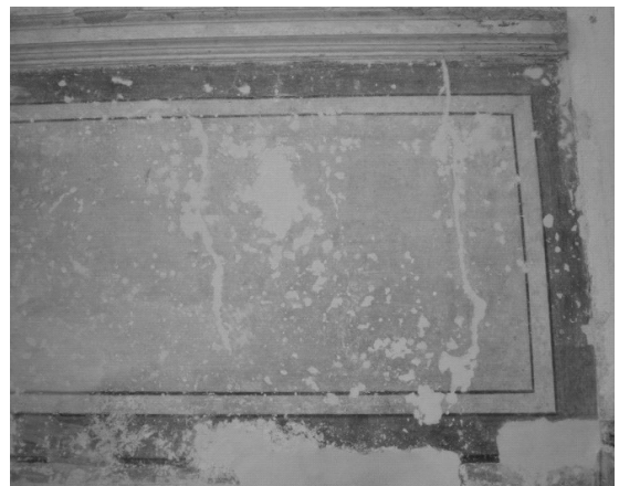
Fig. 6 Chafariz do Largo de São Mamede: preenchimento das lacunas com argamassas.
