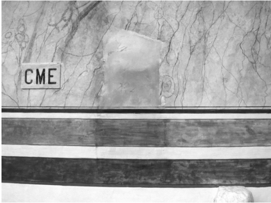
Fig. 10 Chafariz de Alconchel: após preenchimento, procedeu-se à reintegração cromática da área correspondente ao vão de acesso à galeria.
