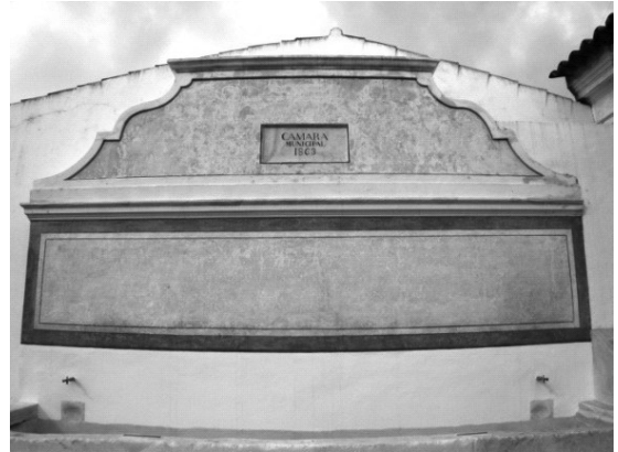
Fig. 12 Chafariz do Largo de São Mamede: vista geral depois da intervenção.
