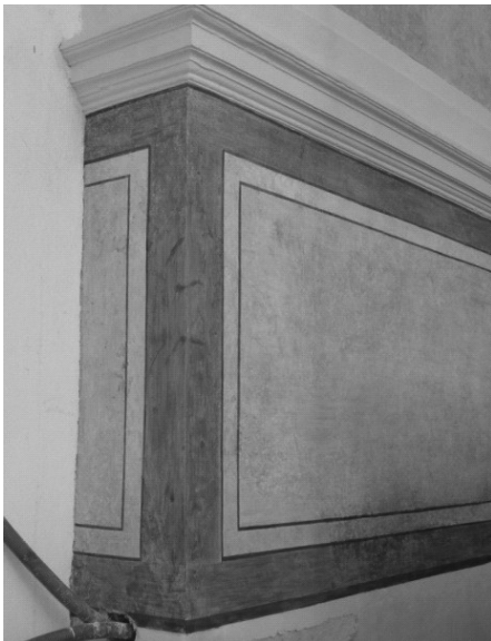
Fig. 8 Chafariz do Largo de São Mamede: aspecto final da mesma superfície apresentada na figura 6 após reintegração cromática das lacunas.
