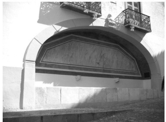
Fig. 14 Chafariz de Alconchel: vista geral depois da intervenção.
