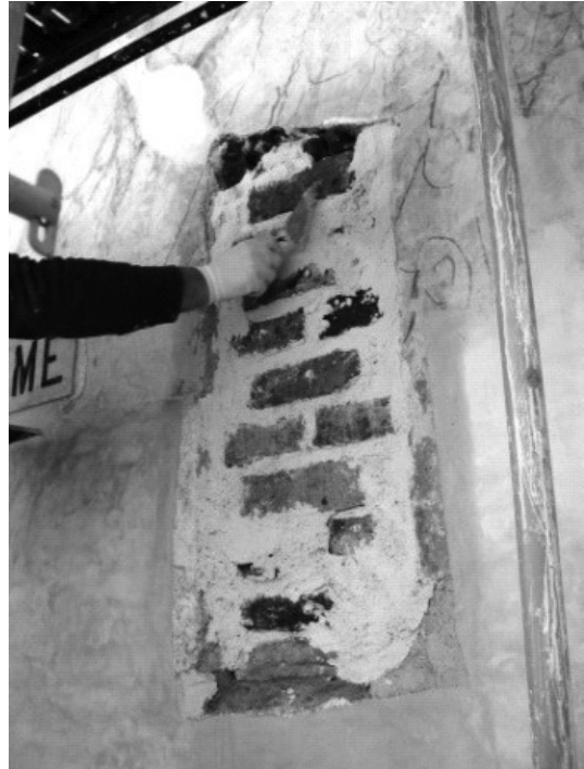
Fig. 9 Chafariz de Alconchel: preenchimento do vão de acesso à galeria com alvenaria de tijolo.
