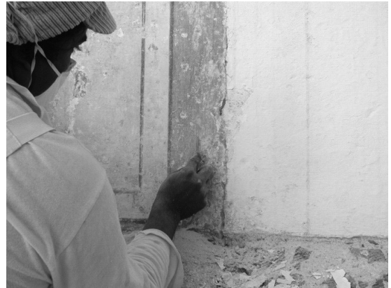
Fig. 5 Chafariz do Largo de São Mamede: levantamento manual e remoção mecânica (por bisturi) das múltiplas camadas de pintura a cal.
