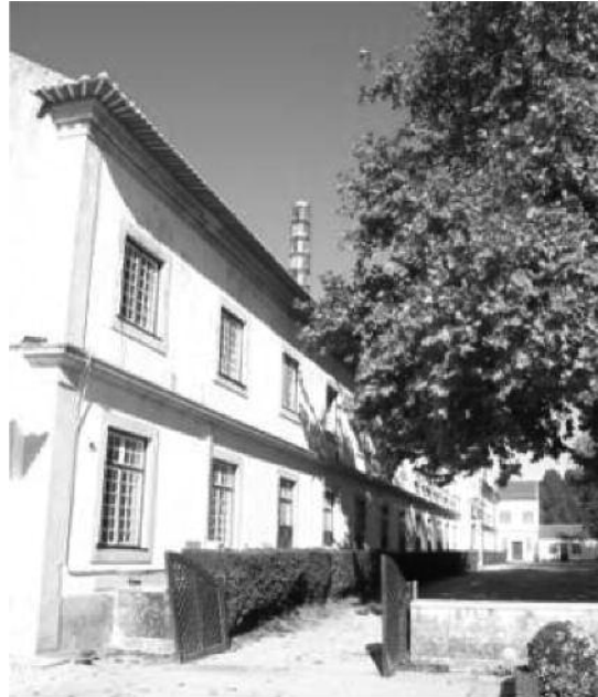
Fig. 1 Edifício da Fábrica (foto: Alice Ruano).
