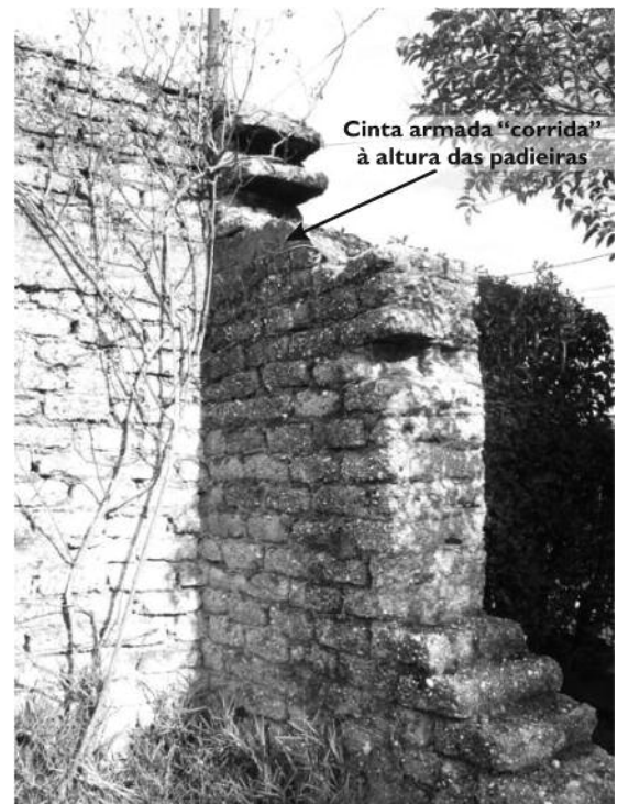
Fig. 37 Arranque de construção de habitação - adobe e cinta de betão armado (foto: Alice Ruano).
