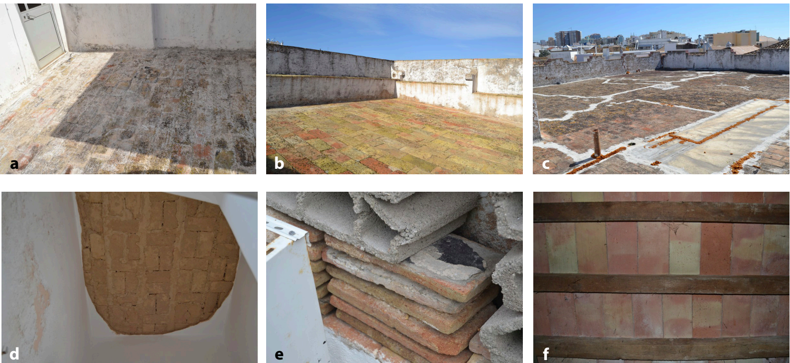
Figura 10. Vista das açoteias tradicionais de Faro (a-c) e pormenores da técnica construtiva dos terraços em Santa Catarina (d-f).
