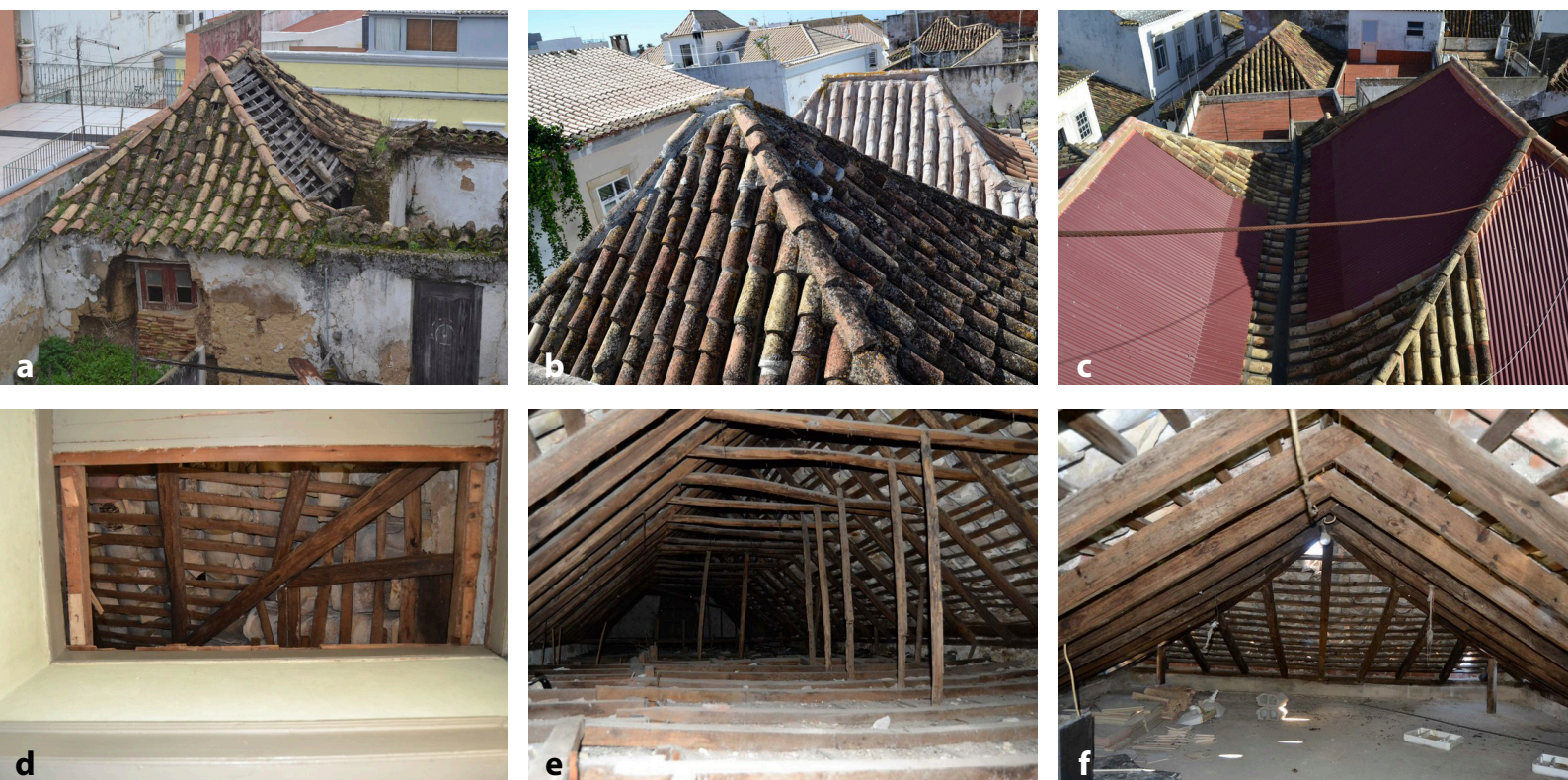
Figura 9. Telhados tradicionais de “tesouro”, vista pelo exterior (a-c), e estrutura de madeira vista pelo interior da cobertura (d-f).
