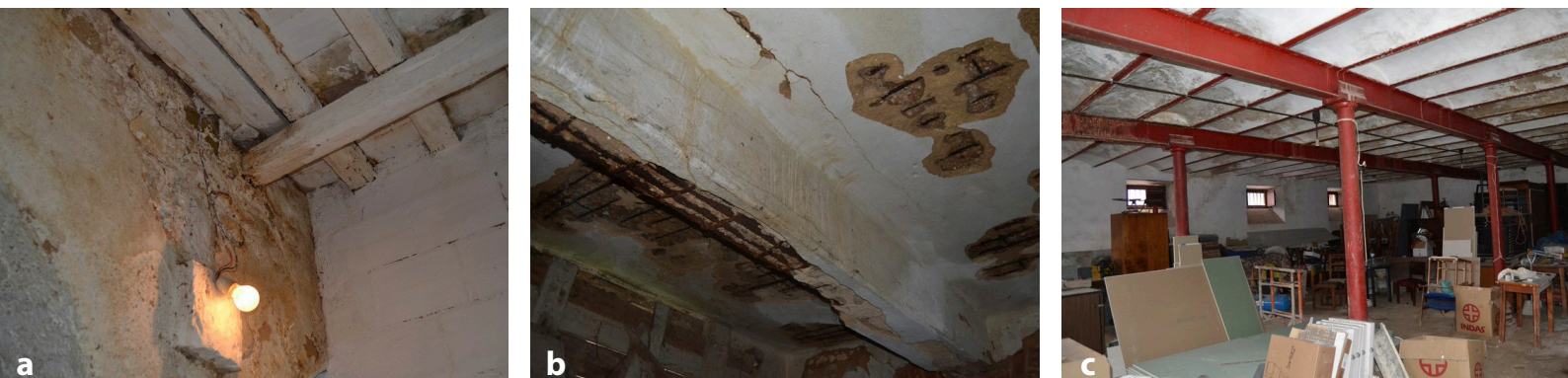
Figura 7. Diferentes soluções construtivas para os diafragmas horizontais, desde a estrutura tradicional de madeira (a), lajes em betão armado de medíocre qualidade, (b) e ainda estruturas mistas abobadadas suportadas por elementos metálicos (c).
