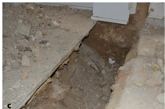
Figura 3. Embasamento típico em alvenaria de pedra.
