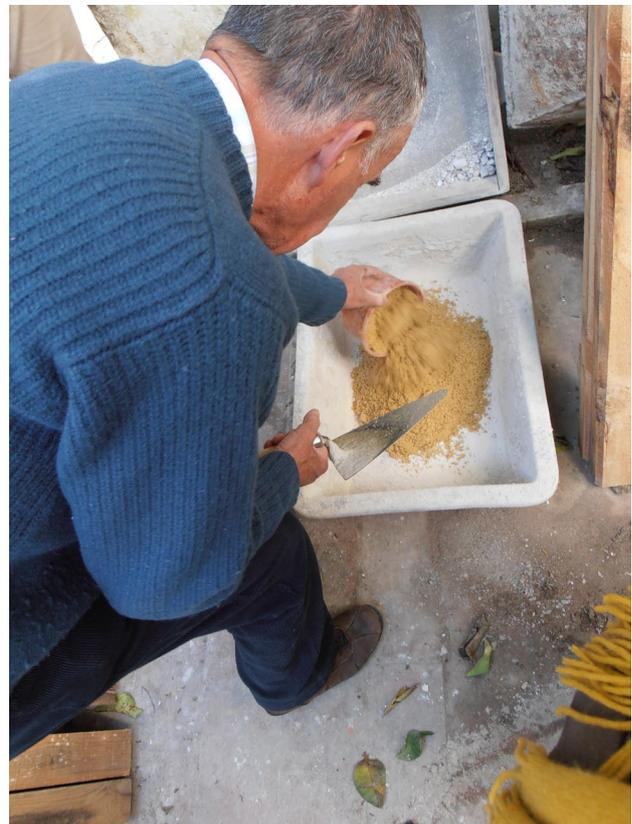
**Figura 6.** Preparação de argamassa de cal.
