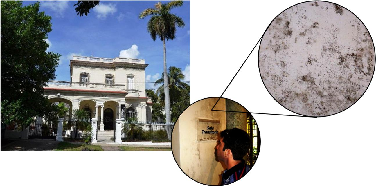
**Figura 1.** Museo Biblioteca Servando Cabrera. Muestra de la infestación fúngica en paredes del vestíbulo después del corte de electricidad que interrumpió el funcionamiento del aire acondicionado central tras el paso de un huracán. La ampliación representa un área de 10 cm<sup>2</sup>.
