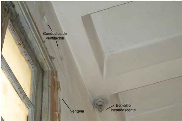
**Figura 10.** Bombillos incandescentes colocados en el techo de los depósitos del ARNAC cerca de los conductos de ventilación.
