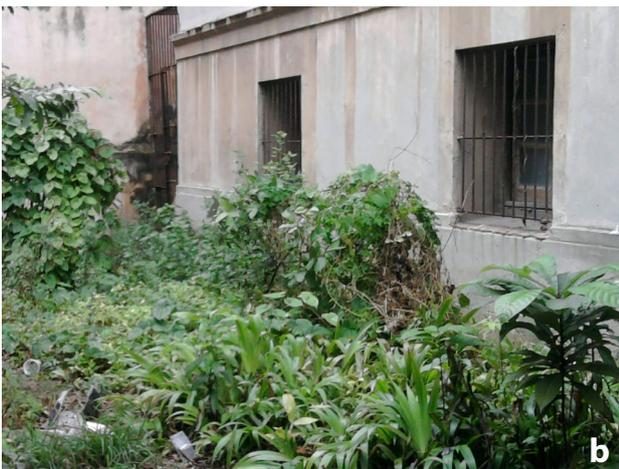
**Figura 6.** Incidencia de la humedad externa en los depósitos del semisótano. *a)* Formación de sales de calcio y desarrollo fúngico en la pared de un depósito a consecuencia de la humedad. *b)* Desarrollo de la vegetación en el exterior de los depósitos durante los primeros meses del 2011 que mantiene la humedad interior.
