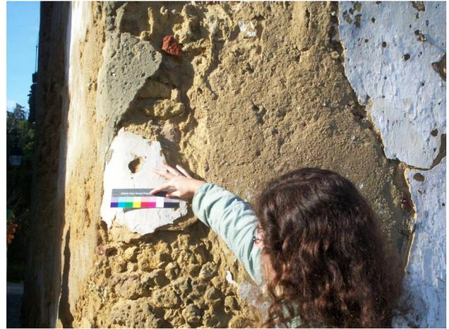
Figura 8. Exame de reboco de pintura com cal.
