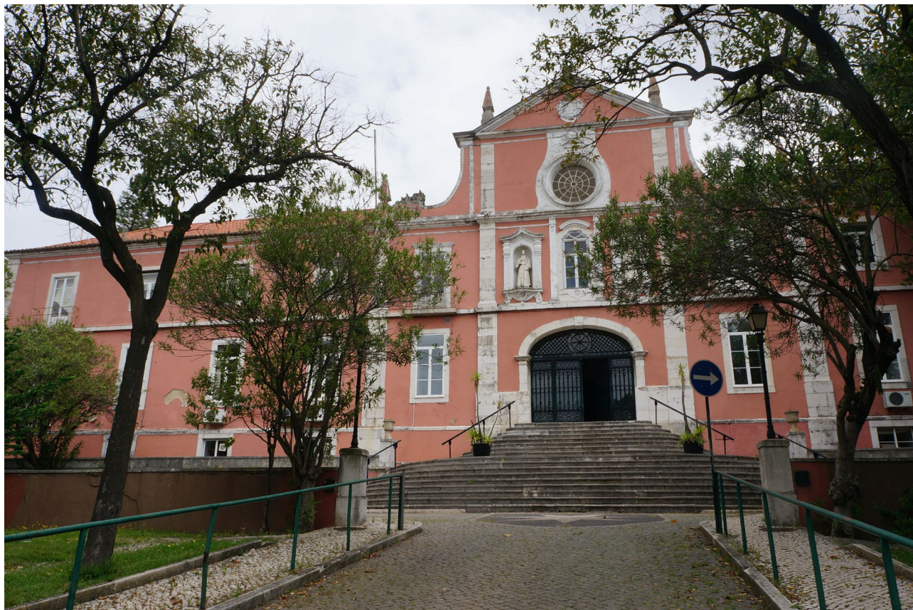
Figura 1. Fachada da igreja de Nossa Senhora da Estrela, Lisboa.
