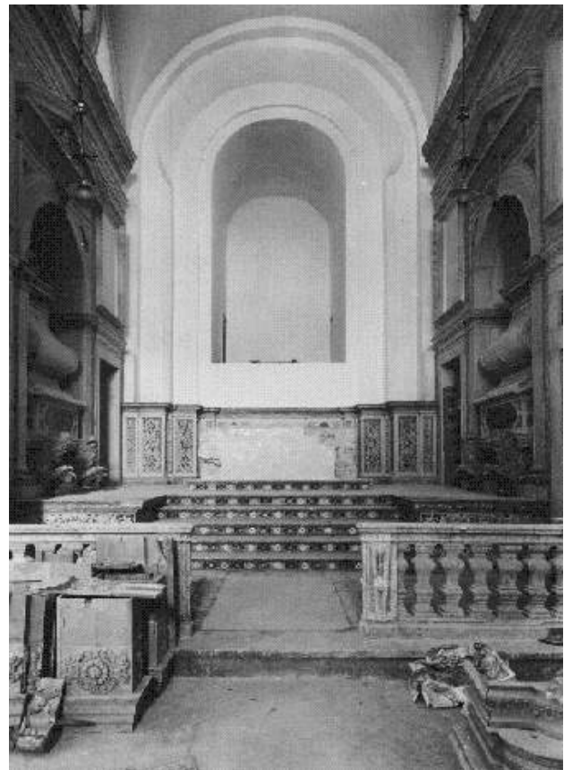
Figura 3. Igreja de Nossa Senhora da Estrela, Lisboa. Obras em curso no ano de 1946. Arquivo Municipal de Lisboa, Kurt Pinto, PT/AMLSB/KPI/000087.
