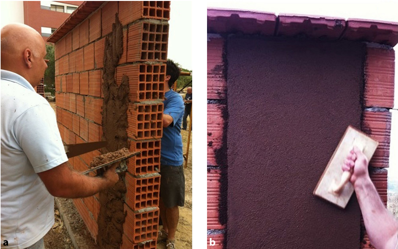
Figura 2. Visualização do início (a) e do final (b) da aplicação dos painéis de reboco exteriores com argamassas à base de terra.
