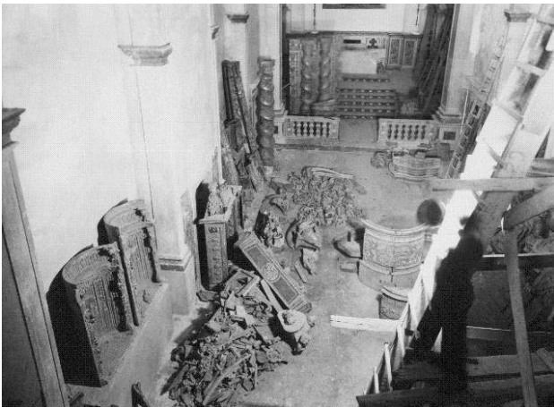
Figura 5. Igreja de Nossa Senhora da Estrela, Lisboa. Obras em curso no ano de 1946. Arquivo Municipal de Lisboa, Kurt Pinto, PT/AMLSB/KPI/000089.
