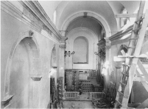
Figura 4. Igreja de Nossa Senhora da Estrela, Lisboa. Obras em curso no ano de 1946. Arquivo Municipal de Lisboa, Kurt Pinto, PT/AMLSB/KPI/000088.
