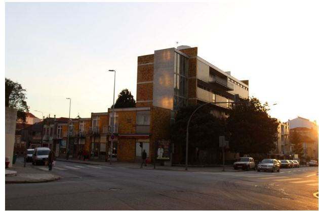
Figura 2. Vista do edifício Parnaso e seu enquadramento no cruzamento da rua Nossa Senhora de Fátima com a rua Oliveira Monteiro, no Porto.
