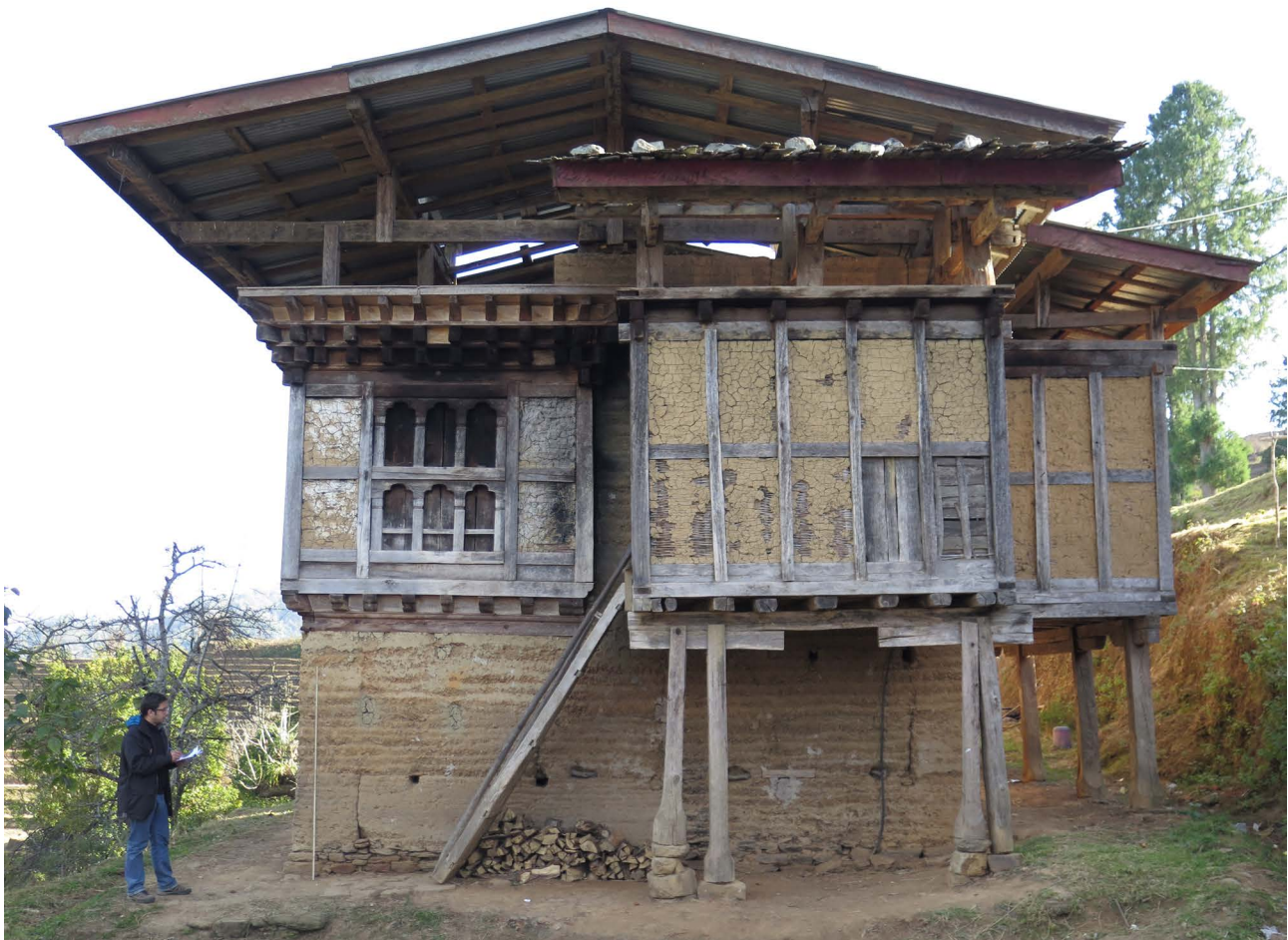
Figura 1. Edifício tradicional butanês em Pathari.
