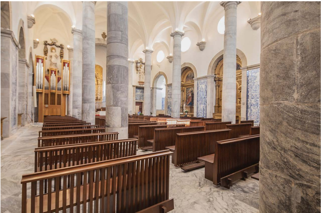
Figura 6. Interior das naves depois das obras.
