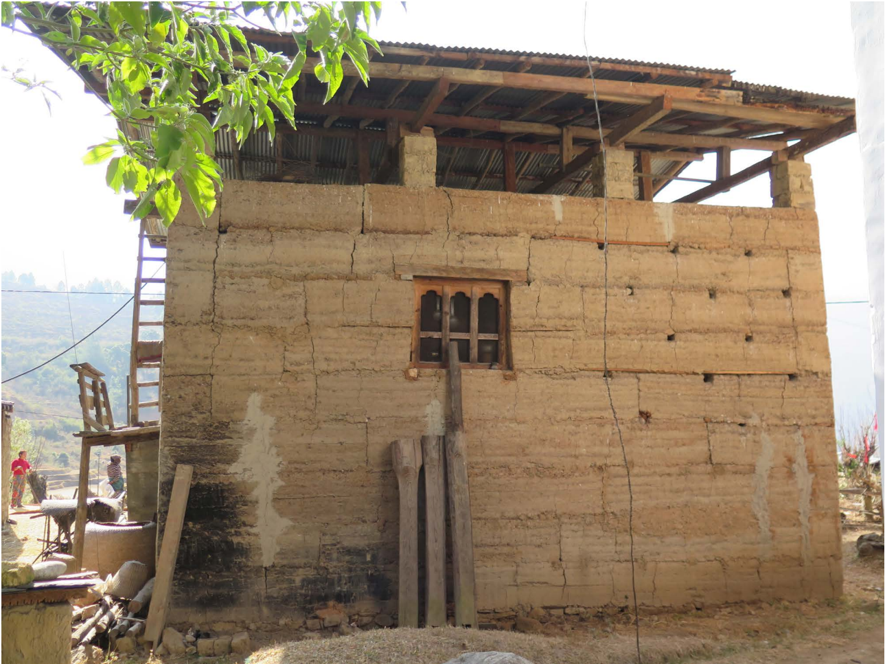
Figura 4. Parede de taipa.
