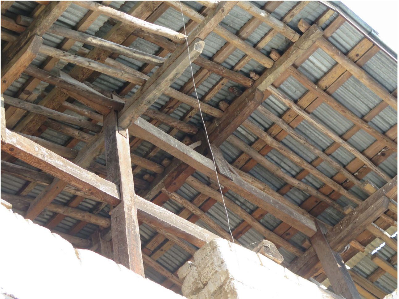
Figura 6. Estrutura da cobertura.
