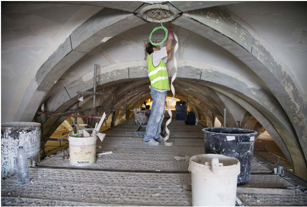
Figura 5. Obras de conservação de rebocos das abóbadas das naves
