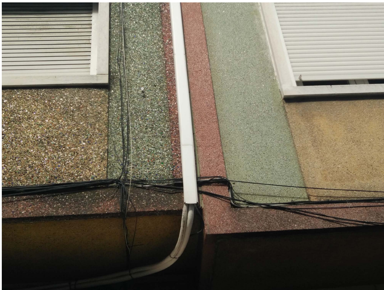
Figura 3. Diferenças de agregados entre edifícios do mesmo estilo na Rua 25 de Abril, Moscavide e Portela.
