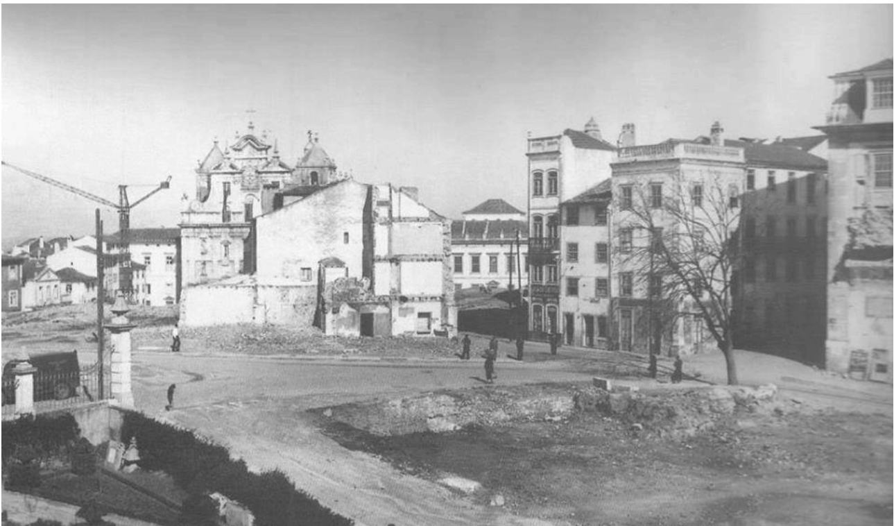
Figura 2. Demolição do Largo do Castelo, actual Praça D. Dinis, Coimbra.
