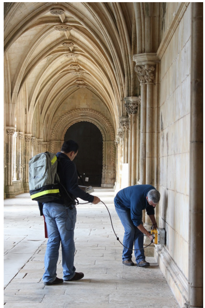
Figura 9. Aquisição GPR a 800 MHz na parede do claustro de D. João I.
