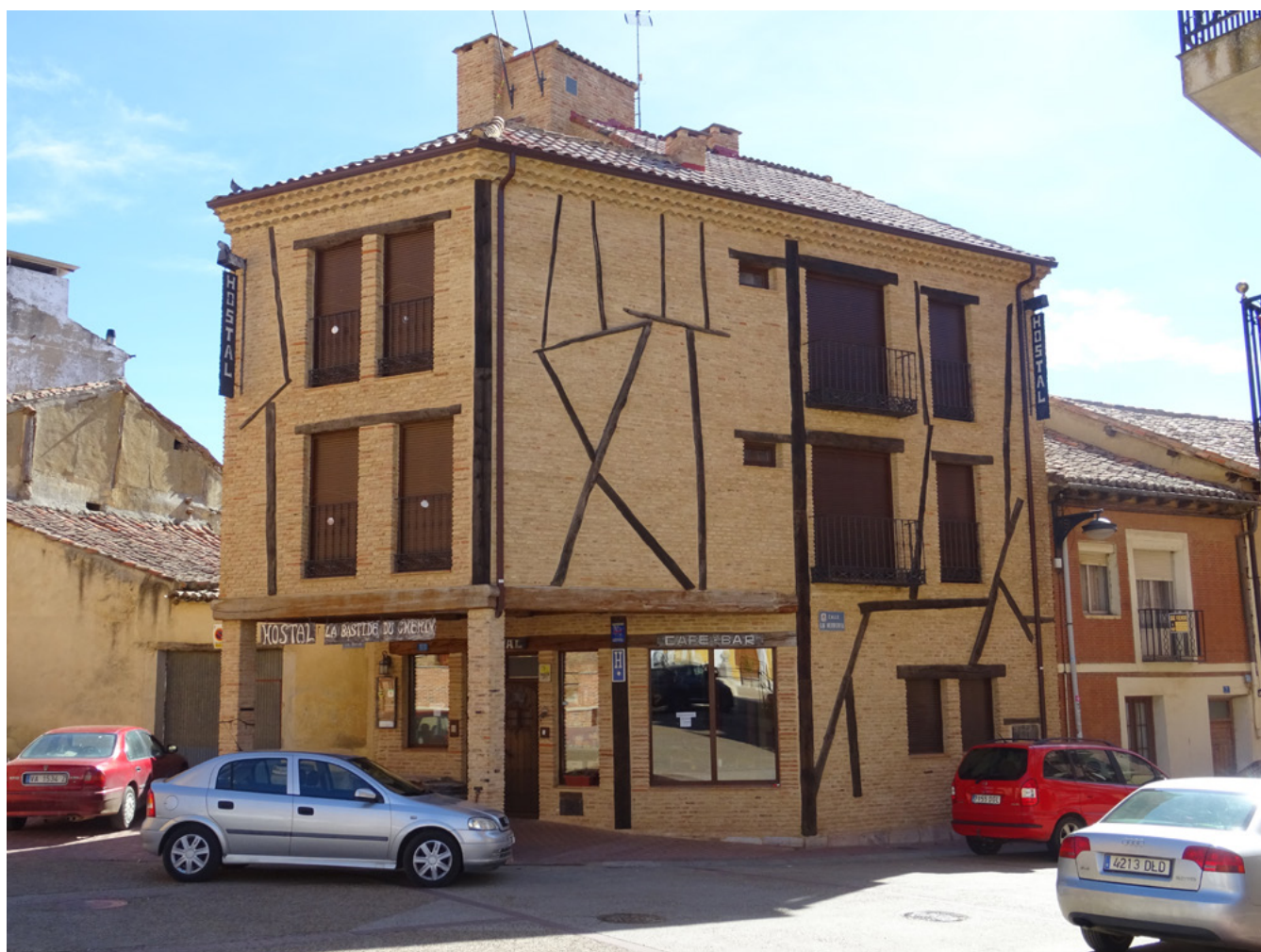
Figura 5. Casa rehabilitada con “estructuras” de madera en Sahagún (León, España). El sueño de la razón produce monstruos.
