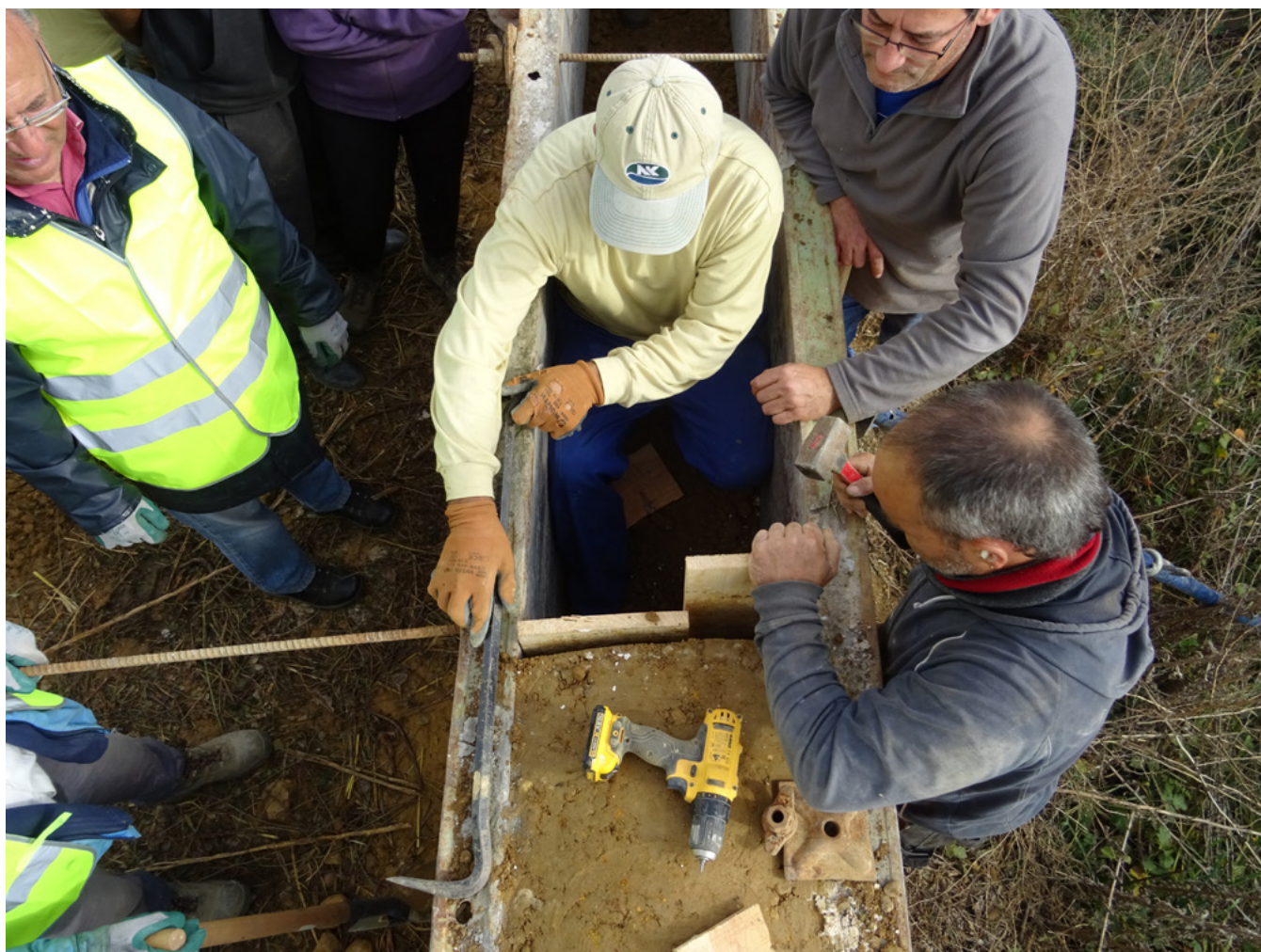
Figura 6. Construcción con tapial en Villaverde de Sandoval (León, España).
