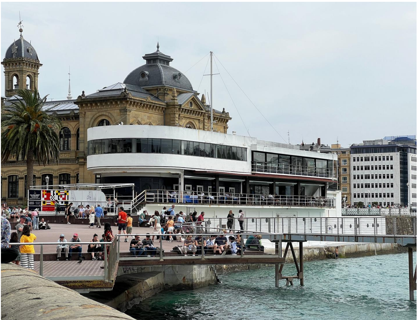
Figura 1. Edificio del RCNSS, Donostia-San Sebastián, Gipuzkoa (Foto: J. García Moreno, 2024).
