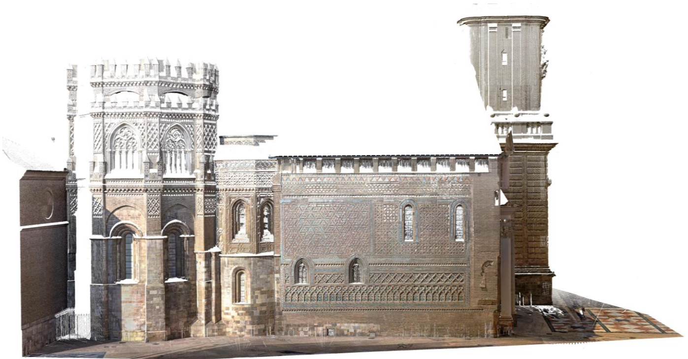
Figura 2. Nube de puntos del exterior de la Parroquieta obtenido mediante escáner láser.
