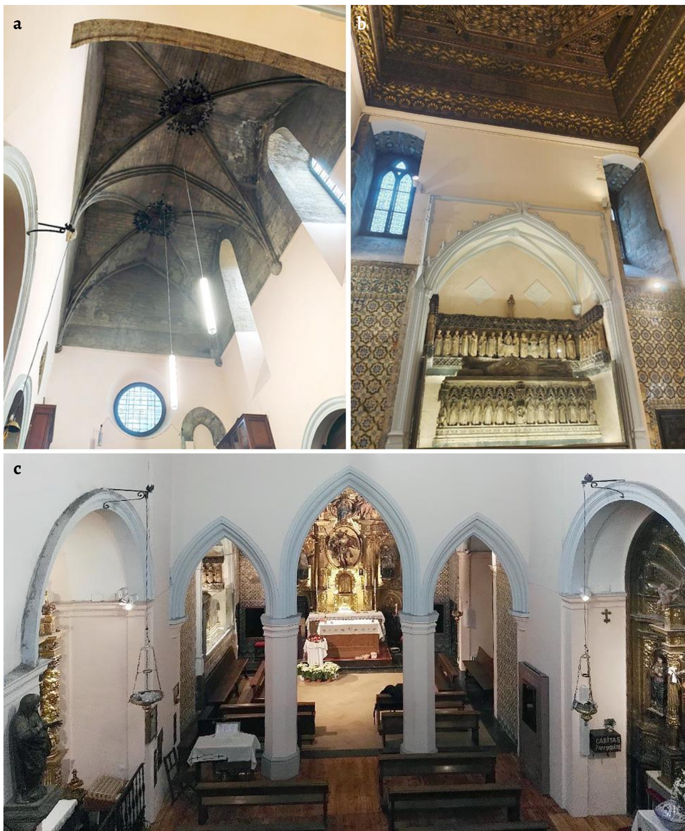
Figura 5. Vistas del interior de la Parroquieta: a) Bóvedas; b) Sarcófago; c) Nave (fotos: Javier Peña).
