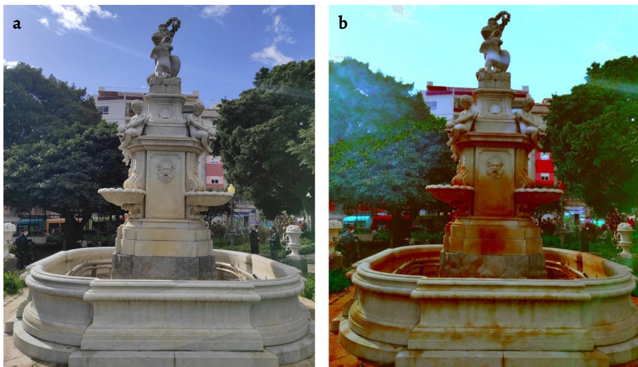
Figura 15. Análisis por imagen: a) Fotografía inicial; b) Misma fotografía tras los parámetros de la aplicación Dstretch . El color anaranjado evidencia el área de extensión de los productos derivados de la colonización biológica.
