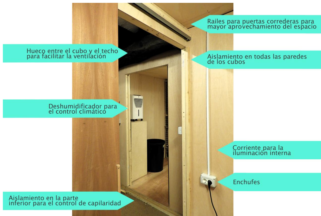
Figura 9. Detalle de los elementos del sistema de almacenaje.
