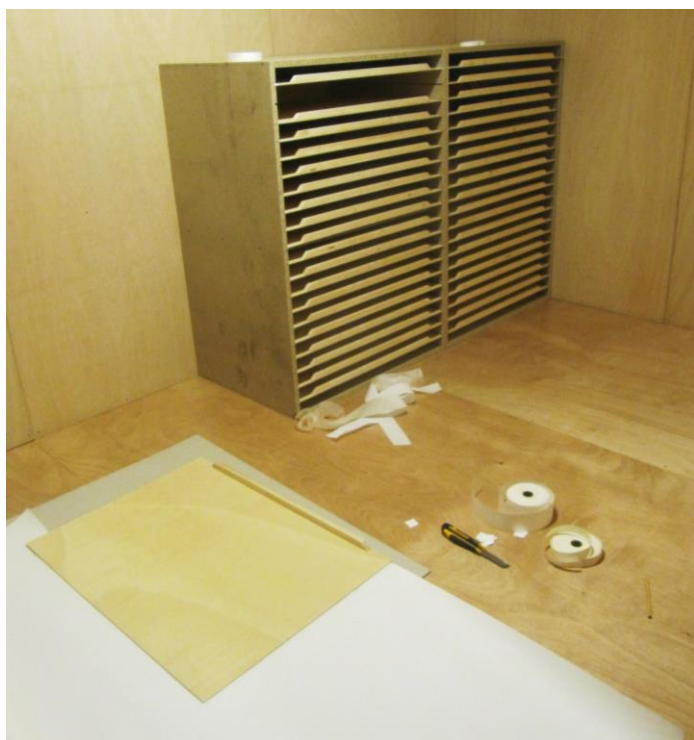
Figura 10. Proceso de colocación y forrado de baldas.
