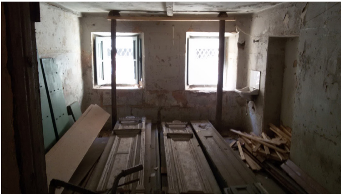
Figura 2. Remoção e armazenamento das portas da fachada frontal no casarão (2013) (foto: Priscila Musa).
