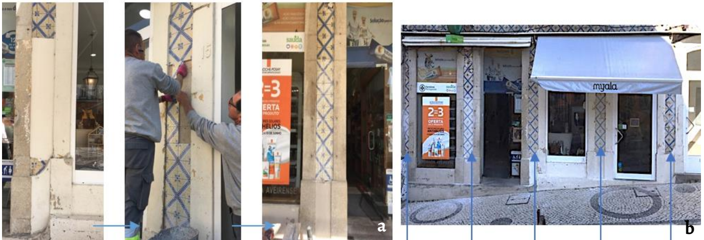
Figura 11. Intervenção na fachada: a) Assentamento dos azulejos (réplicas); b) Após colocação dos azulejos.
