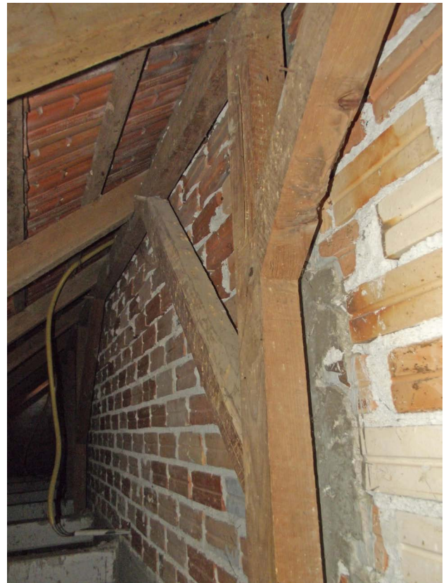
Figura 7. Sótão (lado B) e a estrutura de cobertura da Casa da Cultura.
