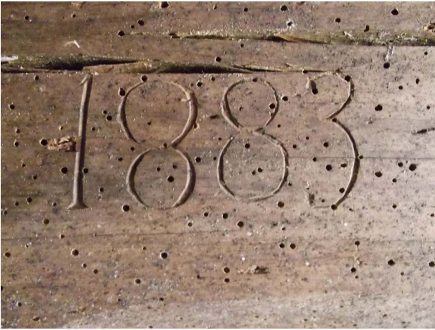
Figura 4. Entalhe da data 1883, que se encontra na casa de troncos localizada na propriedade Cetnarski: observam-se os orifícios de emergência resultado da infestação por insetos na viga de araucária.
