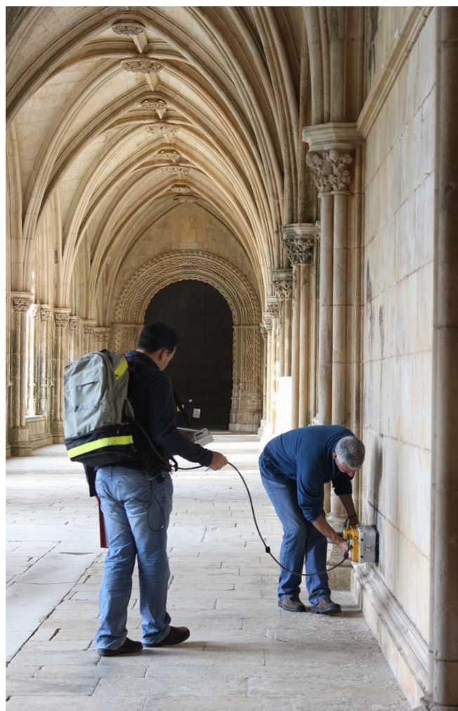
Figura 9. Aquisição GPR a 800 MHz na parede do claustro de D. João I.
