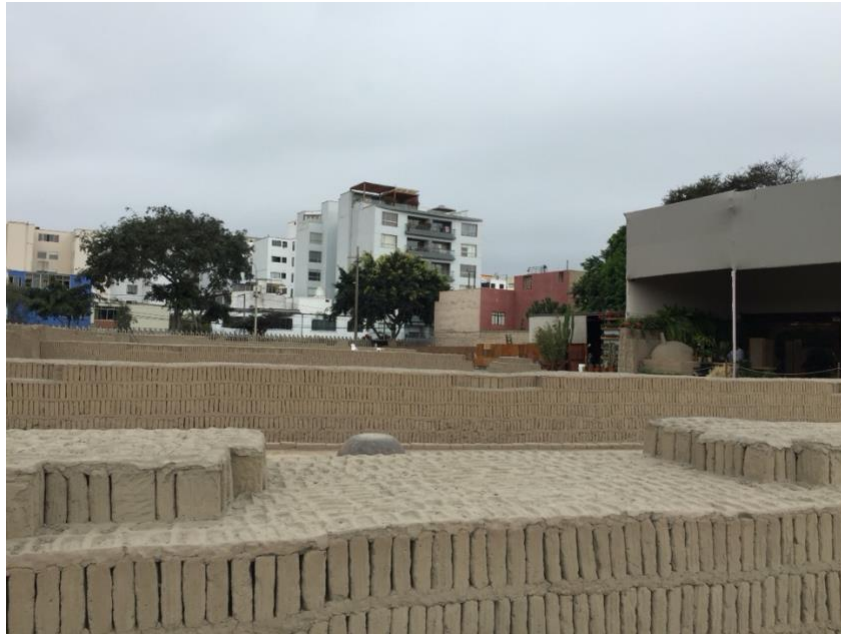
Figura 4. En primer término, hileras de adobe consolidadas y a la derecha el restaurante integrado dentro del complejo de la Huaca Pucllana (Lima, Perú). (Foto: Ana Pastor, octubre 2018).
